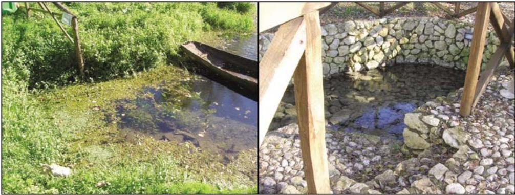
Figura 8 - Aspetto del fondale del lago a ridosso delle sorgenti in assenza (figura a sinistra) e in presenza (figura a destra) di irregimentazione con massi calcarei.
